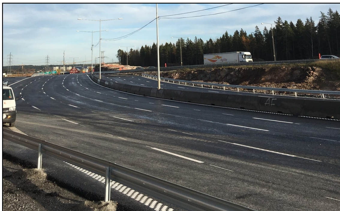
Figur 30: Den nya tillfälliga vägen vid Häggvik i början på november strax före omläggningen. Foto: Alexander Nilsson, Trafik Stockholm
