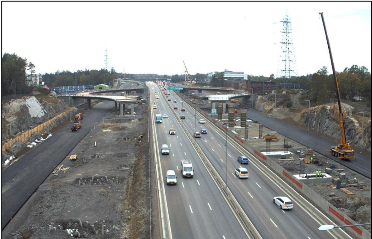
Figur 31: Kungens Kurva, byggskedet av nya körbanor. Där trafiken går på bilden är numera arbetsområde och de nyasfalterade vägarna i bildens ytterkant utgör numera E4/E20. Foto: Trafikverket 2017
