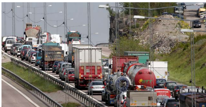
Väg 222, köer mot Skurubron
