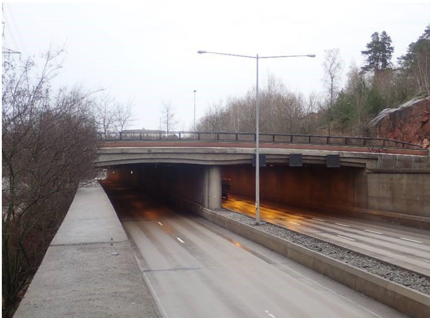
Häggvikstunneln. Foto: Trafikverket
